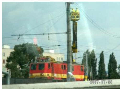
クレーン付きの電気機関車が作業中!
